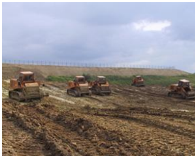
Schürfen im Entnahmebereich
