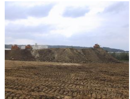
Schütten auf Halde
