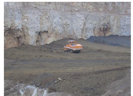
Boden wird lagenweise eingebaut
