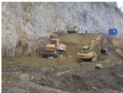
Bagger im Verbund mit der Schürfraupe
