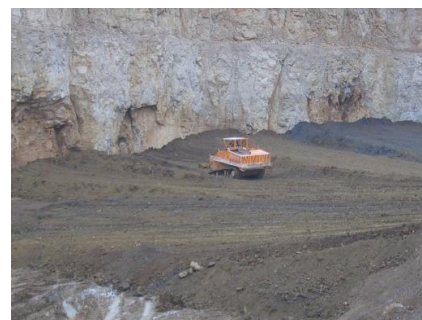
Układanie materiału w warstwy
